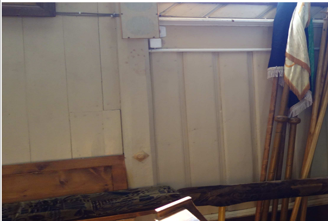
Fot. 10. Widok wewnętrzny – uszkodzona deska na ścianie kaplicy
